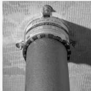
Przykład montażu kolnierza PYROPLEX® PPC4
